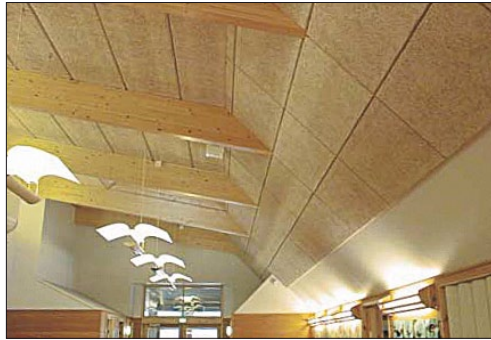
T-tak kattorakenne, Lastentarha, Leppävaara.
